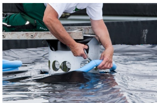
Installatie ring rondschuim / installation foam ring
