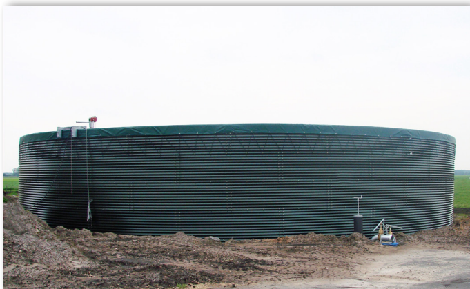
Silo en acier
