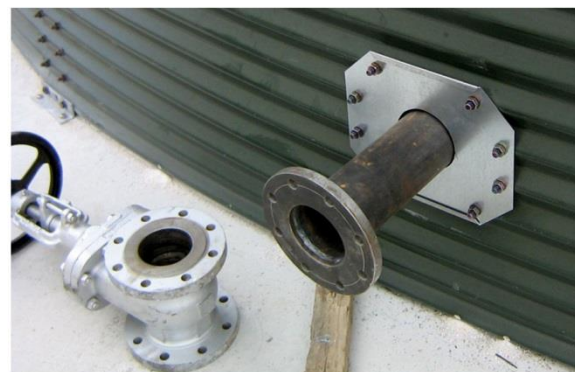
Silowanddoorvoer
